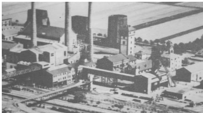
Luftaufnahme vom Georgschacht mit Zechenhaus, Wasserturm, Fördergerüsten und Kohlenaufbereitung u. Elektrischer Zentrale (Bild-Auszug aus W. Weiland, 1980)
