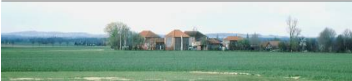
Blick nach Norden zum Ostschacht (Photo: G. Römhild, 1990)
