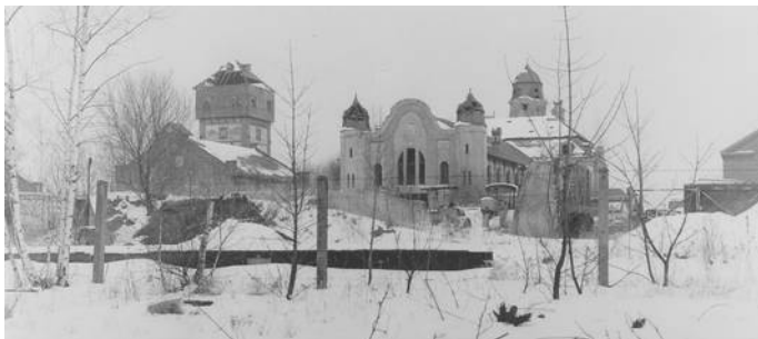
Der Georgschacht mit Zechenhaus, Fördermaschinenhaus I und Wasserturm;
